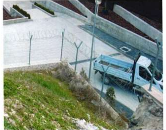
RESİM 11- Gökköy mahallesi, 205 Ada, 2 Parsel etrafındaki betonarme istinat duvarı, kafes tel örgü panel çit ve helejonik jiletli tel çitlerden bir görünüş.
