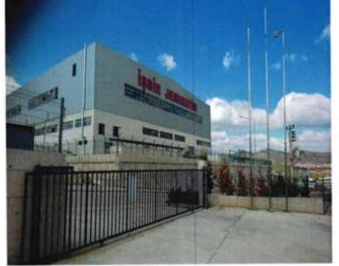
RESİM 9- Gökköy mahallesi, 205 Ada, 2 Parsel üzerinde beton zemin, sürgülü demir kapı ve bayrak gönderlerinden bir görünüş.
