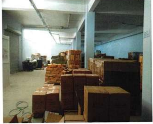
RESİM 3- Gökköy mahallesi, 205 Ada, 2 Parsel üzerindeki fabrika binasının bodrum katındaki ambalajlama bölümünden bir görünüş.
