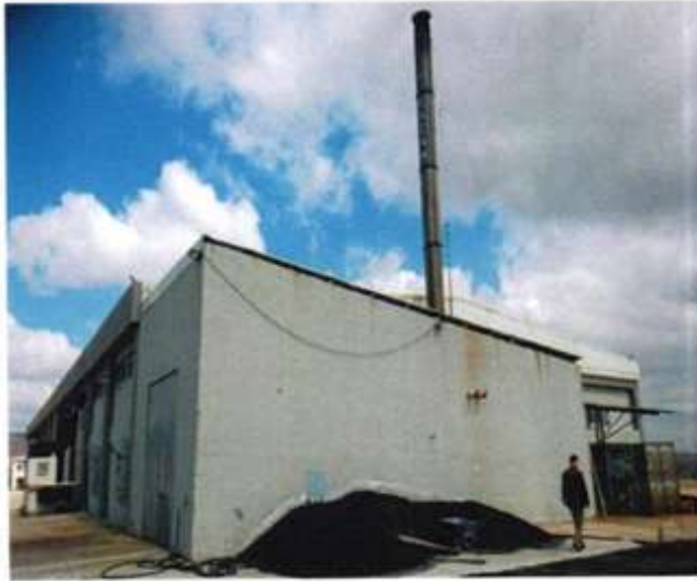
RESİM 8- Gökköy mahallesi, 205 Ada, 2 Parsel üzerindeki fabrika binasının yan tarafındaki kazan dairelerinden bir görünüş.
