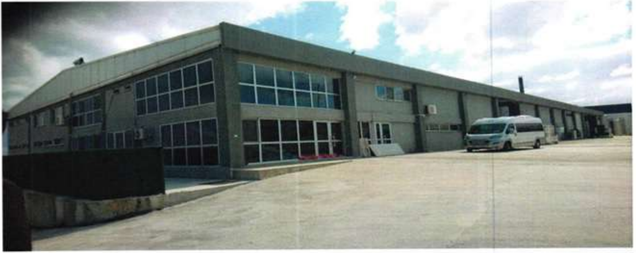
RESİM 1- Gökköy mahallesi, Organize Sanayi 1.Bölgedeki 205 Ada, 2 Parsel üzerindeki fabrika binasından bir görünüş.
