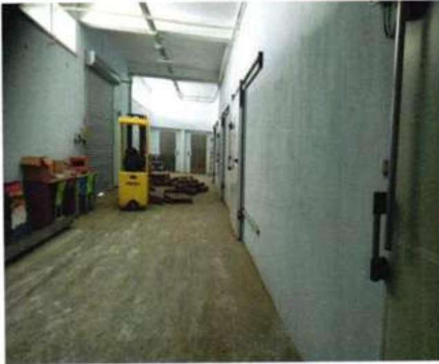
RESİM 2- Gökköy mahallesi, 205 Ada, 2 Parsel üzerindeki fabrika binasının bodrum katında holden bir görünüş.
