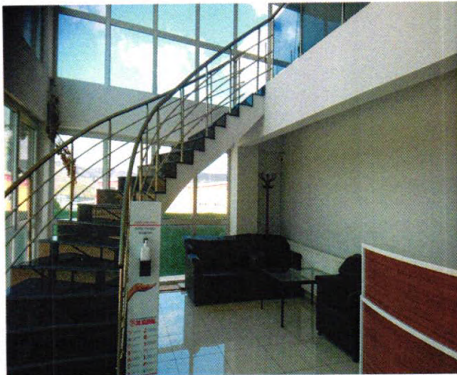
RESİM 4- Gökköy mahallesi, 205 Ada, 2 Parsel üzerindeki fabrika binasının Zemin Kat giriş bölümünden bir görünüş.
