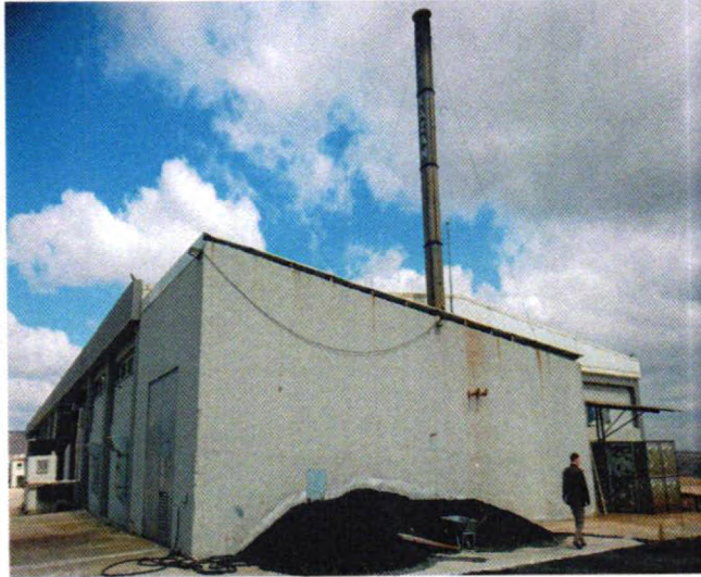
RESİM 8- Gökköy mahallesi, 205 Ada, 2 Parsel üzerindeki fabrika binasının yan tarafındaki kazan dairesinden bir görünüş.
