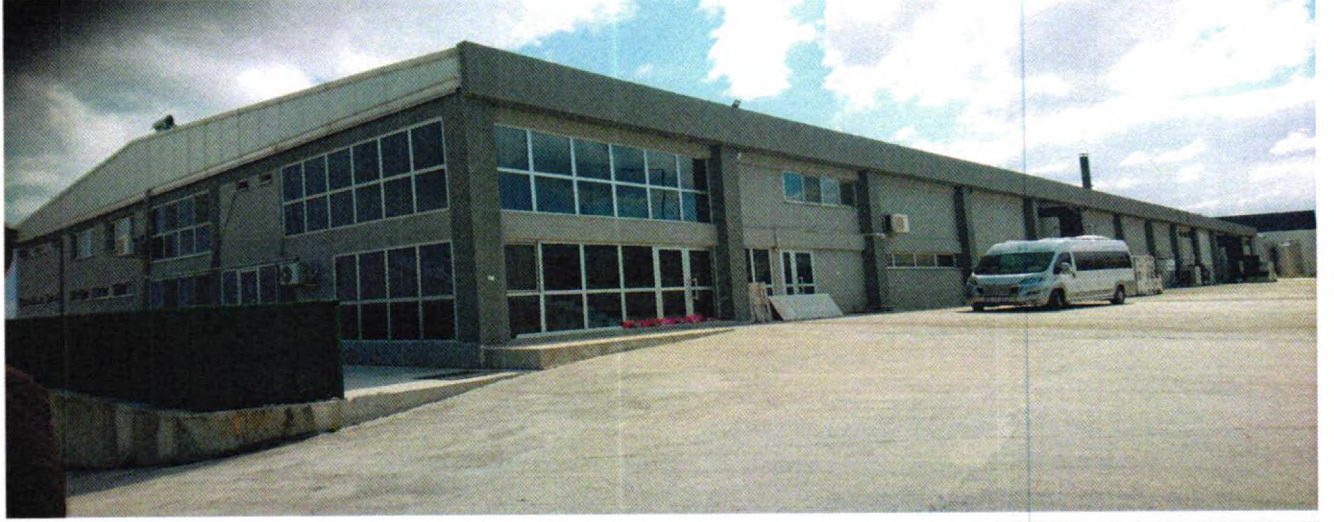
RESİM 1- Gökköy mahallesi, Organize Sanayi 1.Bölgedeki 205 Ada, 2 Parsel üzerindeki fabrika binasından bir görünüş.
