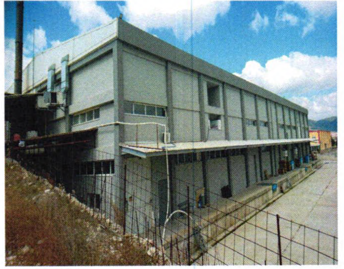
RESİM 7- Gökköy mahallesi, 205 Ada, 2 Parsel üzerindeki fabrika binasının arka cephesinden, sundurmadan, yükleme rampalarından bir görünüş.
